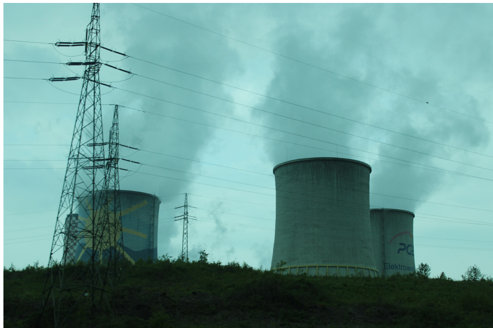
Widok elektrowni (for. Piotr Lewandowski)
